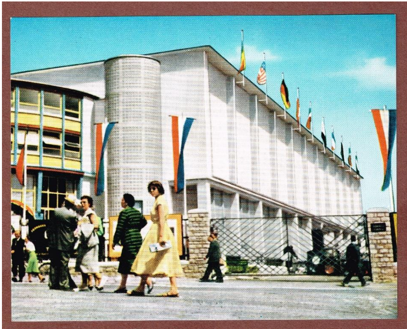
Le nouveau bâtiment des halles de la Foire, milieu années 60 © Joseph Petit
